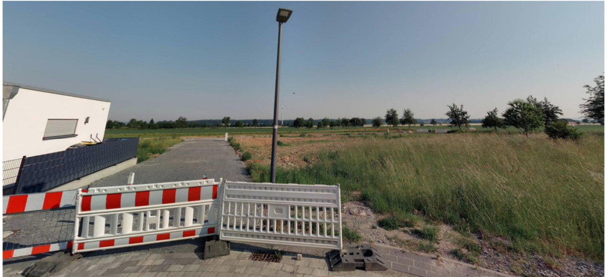
Baustraße – Verlängerung 'Almeschlag' Richtung Norden (Quelle: StreetSmart by Cyclomedia)
