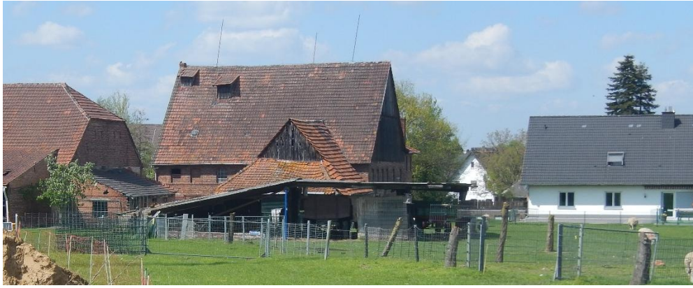
Abb. 2-17: Hofgebäude und Wohnhaus im Nordwesten des Änderungsbereichs 8.1 (Blick SO nach NW)
