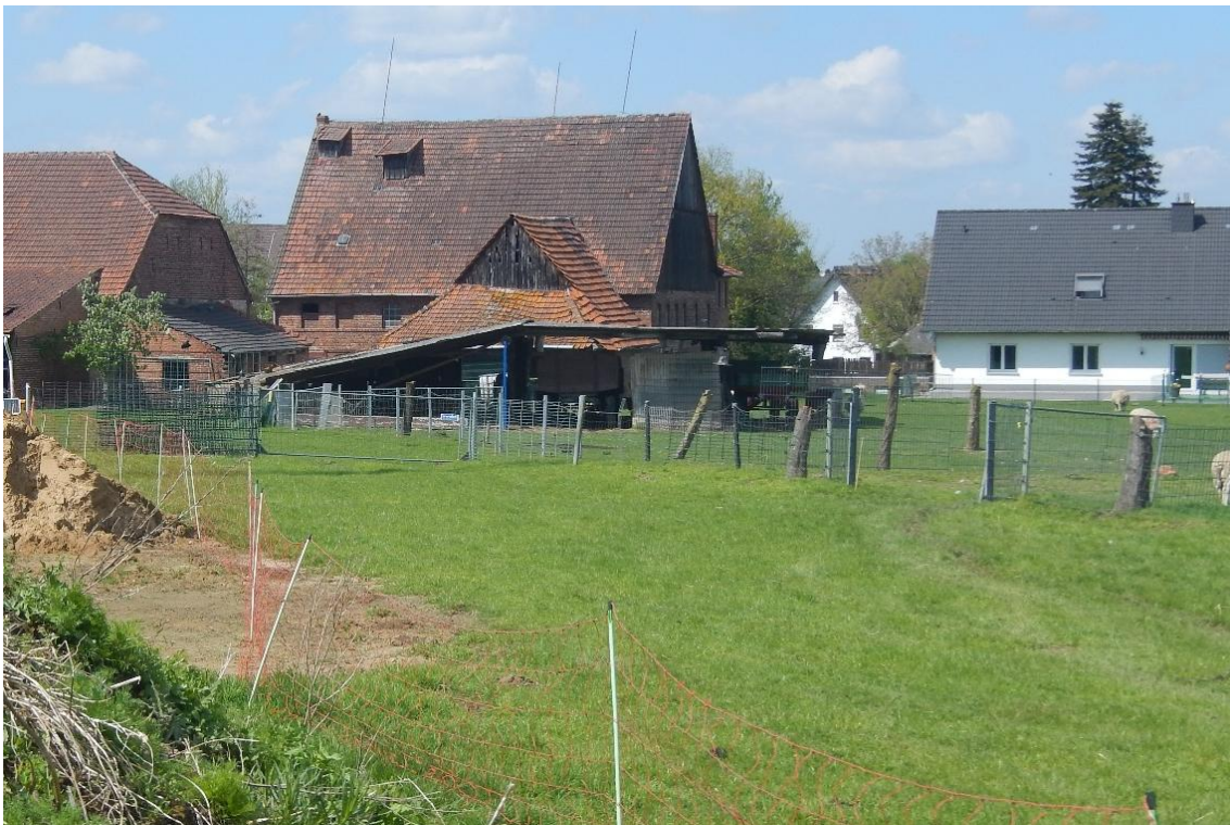
Abb. 5-9: Hofgebäude und Wohnhaus im Nordwesten des Änderungsbereichs 8. 1 (Blick SO nach NW)
